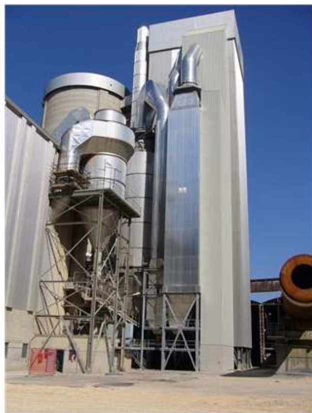
图 1. SCR 反应器应用在蒙塞利切水泥厂
